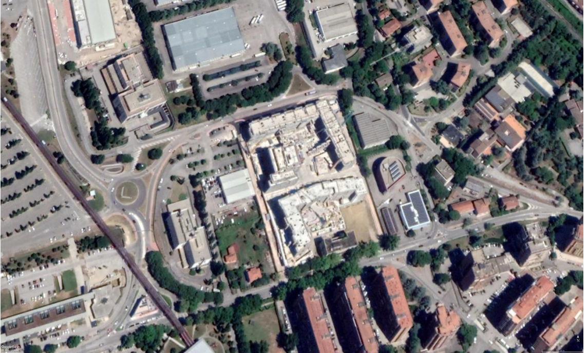
Figura 196. Area oggetto di riqualificazione urbana (ad intervento ultimato)
