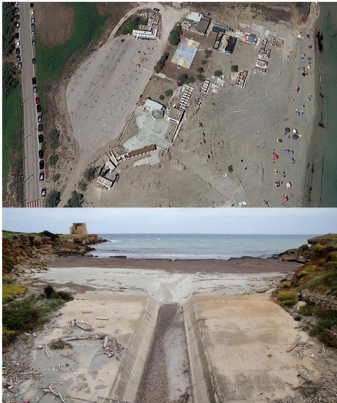
Figura 202. Stato attuale dei luoghi: balneare dismesso (in alto) e Foce del Canale Giancola e Torre Testa (in basso)
