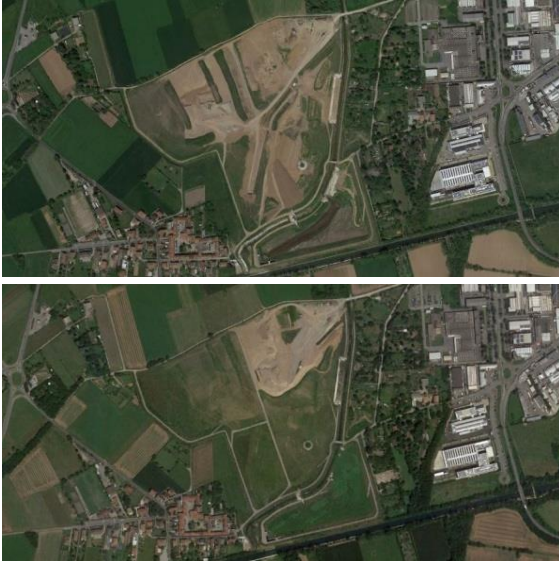
Figura 39. L'area di cantiere presso il comune di Nerviano (Milano), sopra al 2019 e sotto l'area ripristinata al 2020
