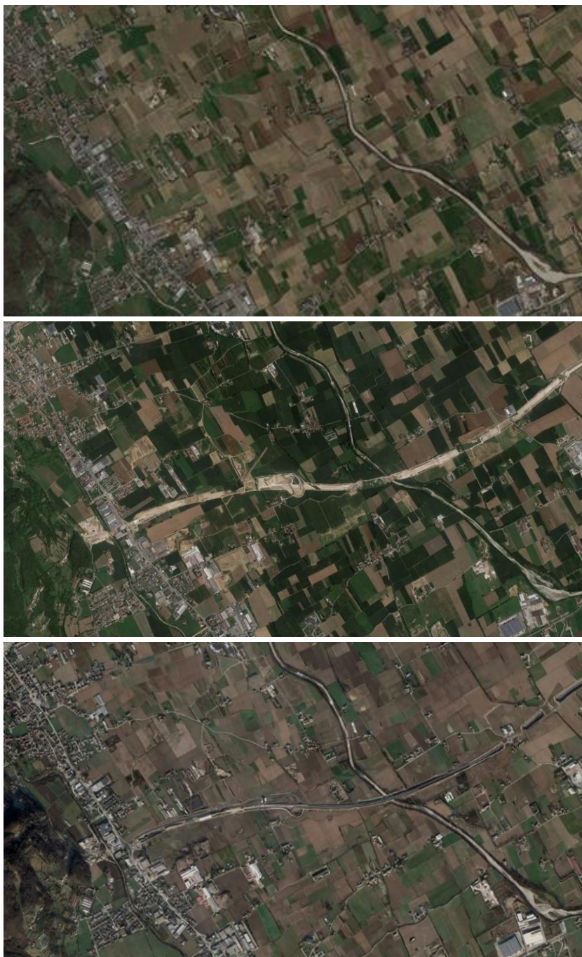
Figura 108. Cantieri stradali per la Pedemontana Veneta nel comune di Malo (VI); immagine 2014 in alto, 2016 in centro, 2020 in basso. Tra il 2014 e il 2020 i cantieri della Superstrada Pedemontana Veneta, hanno occupato circa 580 ettari tra le province di Treviso e Vicenza
