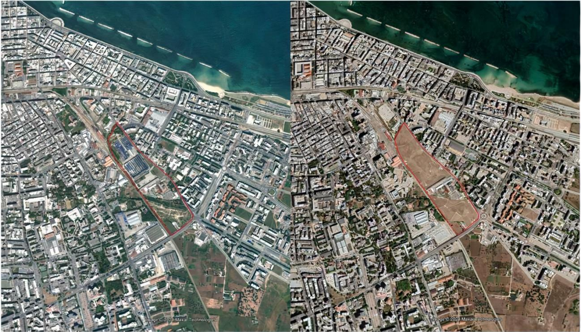
Figura 197. Area oggetto di bonifica e di riconversione dell'uso di suolo prima (sinistra) e dopo l'esecuzione dei lavori (destra)
