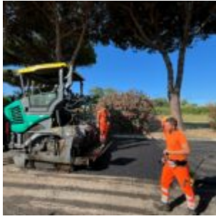
rinnovo manto stradale a Cerenova
