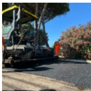
rinnovo manto stradale a Cerenova
