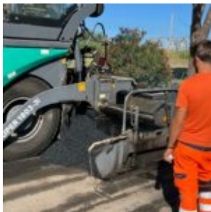
rinnovo manto stradale a Cerenova
