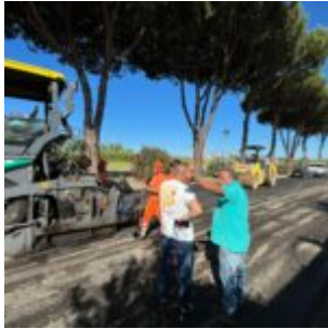
rinnovo manto stradale a Cerenova
