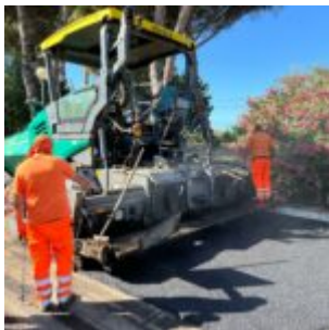
rinnovo manto stradale a Cerenova
